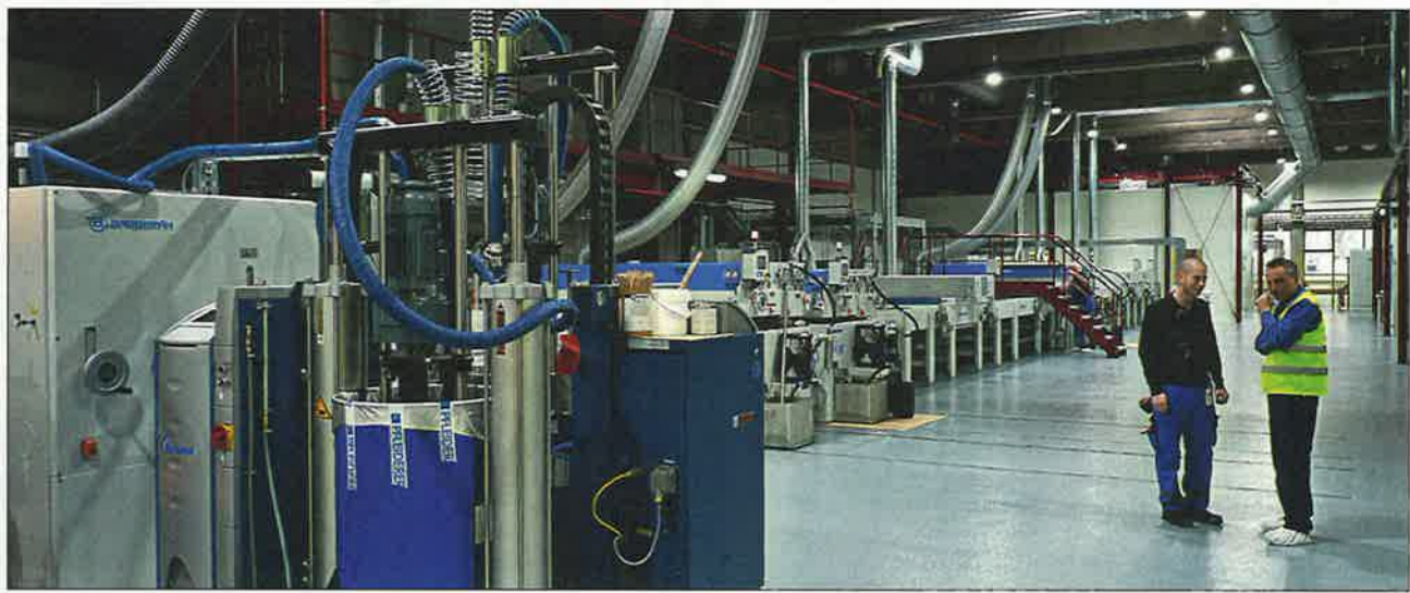
Bei Pfeiderer in Leutkirch (Allgäu) steht aktuell die größte „Hot Coating“-Anlage der Welt. Anfang 2018 wurde sie in Betrieb genommen. Foto: Kleiberit
